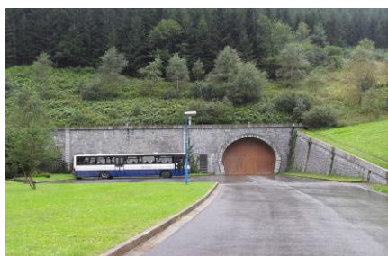
Obr. 14: Vchod do kaverny
