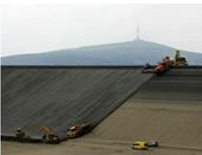
Obr. 4: Oprava horní nádrže
