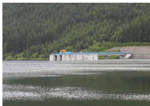
Obr. 26: Hráz dolní nádrže
