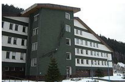
Obr. 13: Řídicí budova vodní elektrárny
