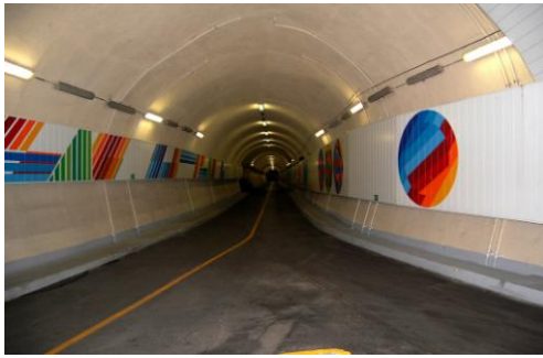
Obr. 15: Tunel vedoucí do kaverny
