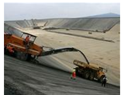
Obr. 6: Oprava horní nádrže
