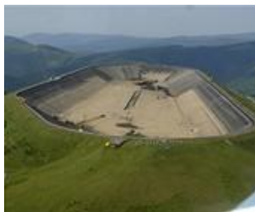
Obr. 5: Celkový pohled na rekonstrukci nádrže
