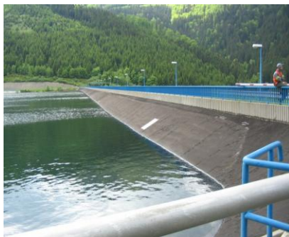
Obr. 8: Hráz dolní nádrže
