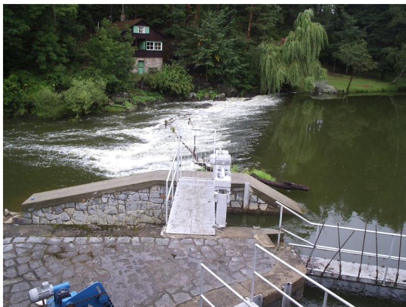
Obr. 9: Pohled na jez a jalovou propust
