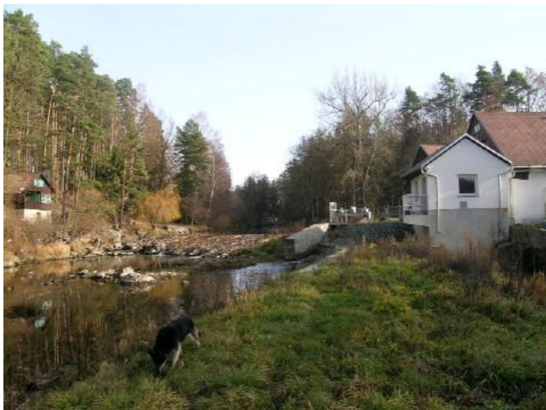
Obr. 6: Celkový pohled na jez a strojovnu malé vodní elektrárny Vaňkův mlýn
