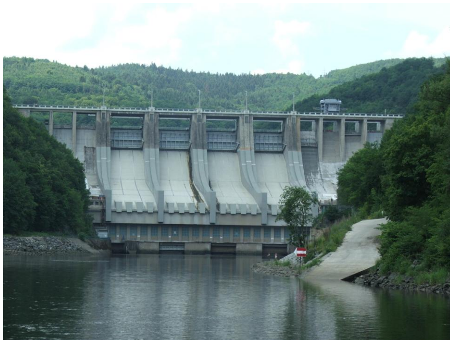
Obr. 4: Přehradní vodní elektrárna Slapy
