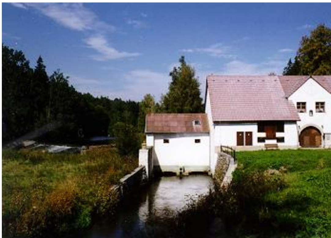
Obr. 3: Malá vodní elektrárna na Nežárce - majitel pan Beránek
