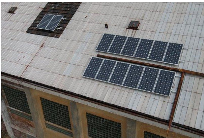
Obr. 5: Umístění panelů na střeše tělocvičny
