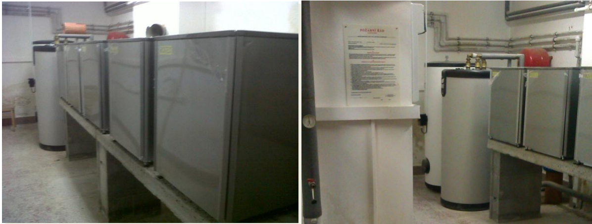
Obr. 12 a 13: Umístění vnitřních jednotek ROTEX [9], [10]
