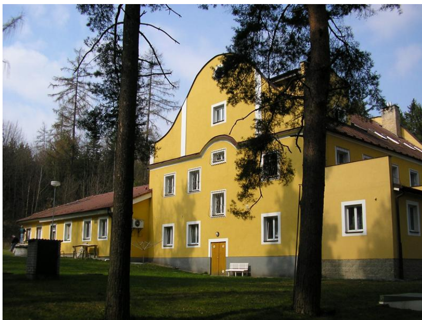
Obr. 5: Objekt ISCS Odlochovice [9]
