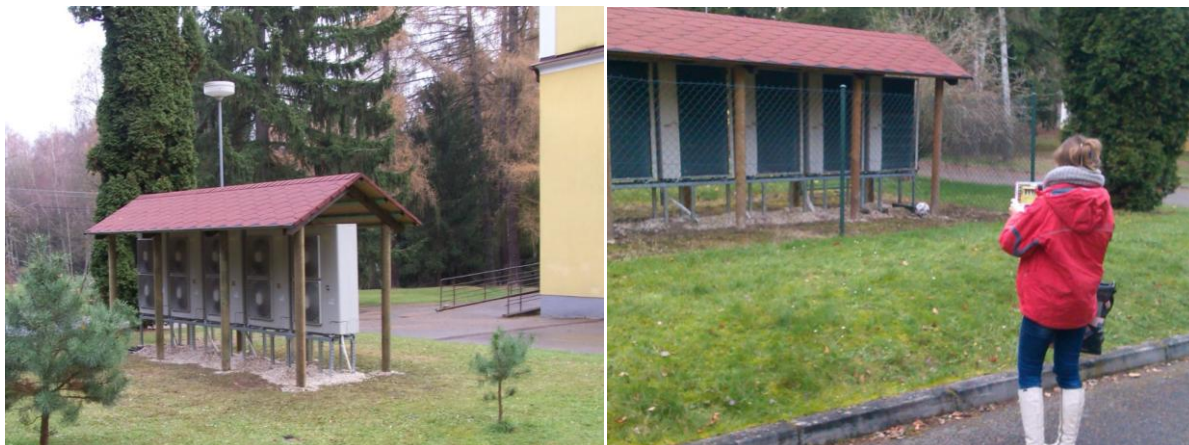
Obr. 10 a 11: Umístění venkovních jednotek ROTEX [9], [10]
