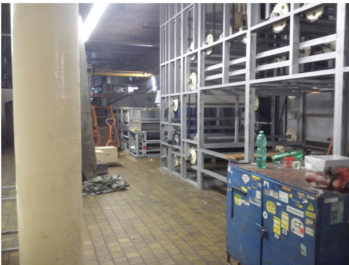
Obr. 15: Stavba nové pece na pečivo [6]
