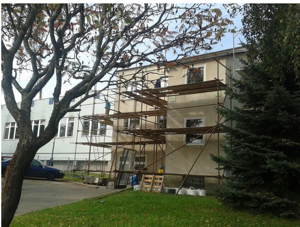
Obr. 14: Zateplování ubytovny [6]
