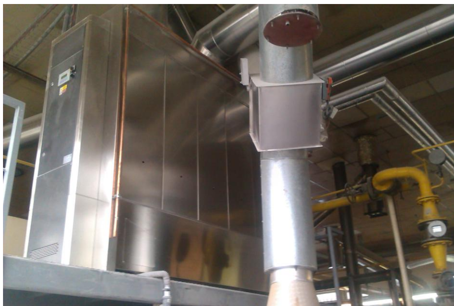
Obr. 9: Klapky a EkoBlok u chlebové pece [6]
