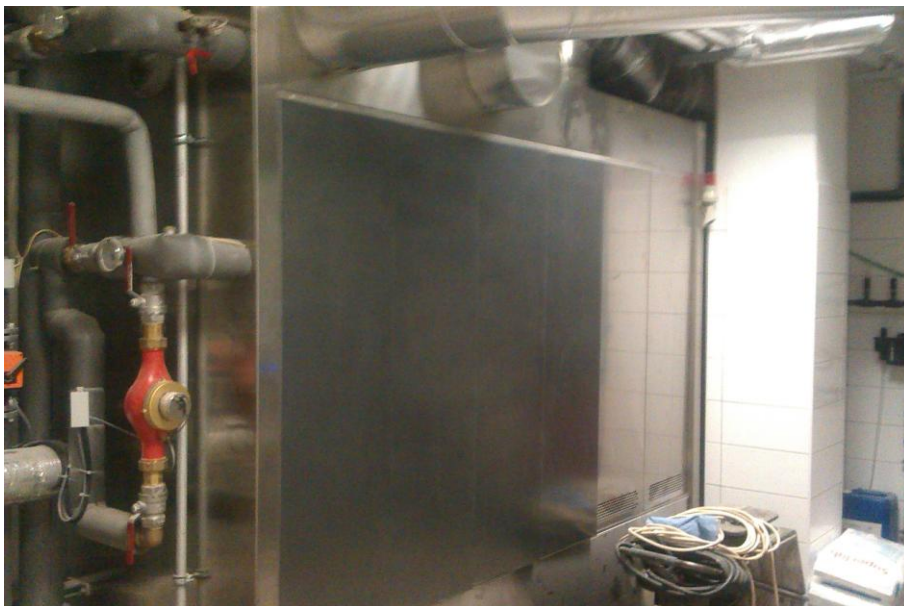
Obr. 11: EkoBlok u pece na pečivo [6]
