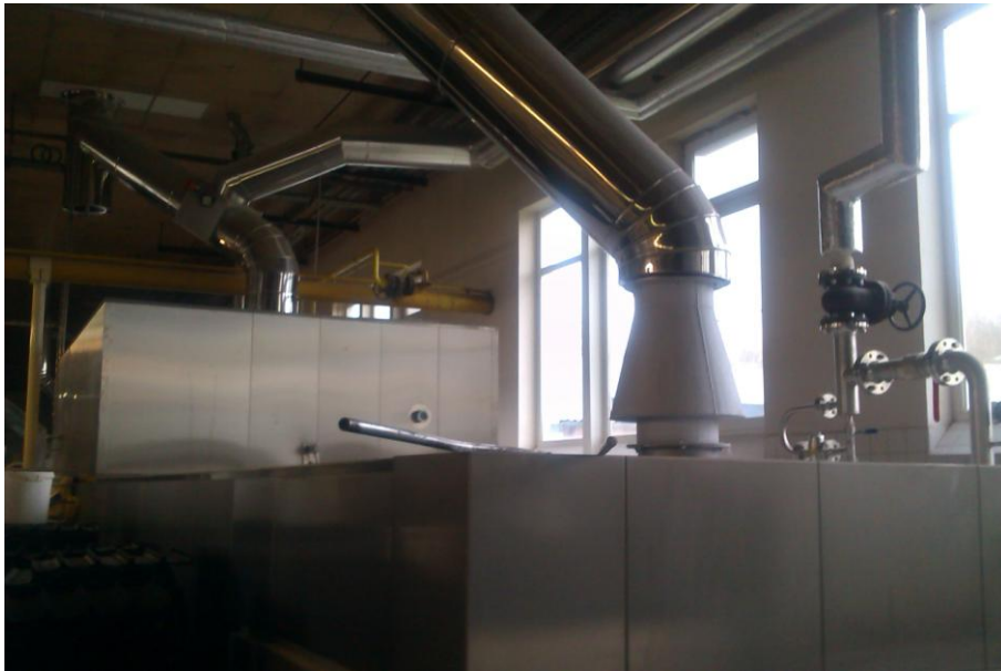
Obr. 10: Odvod spalin z nové pece na pečivo [6]
