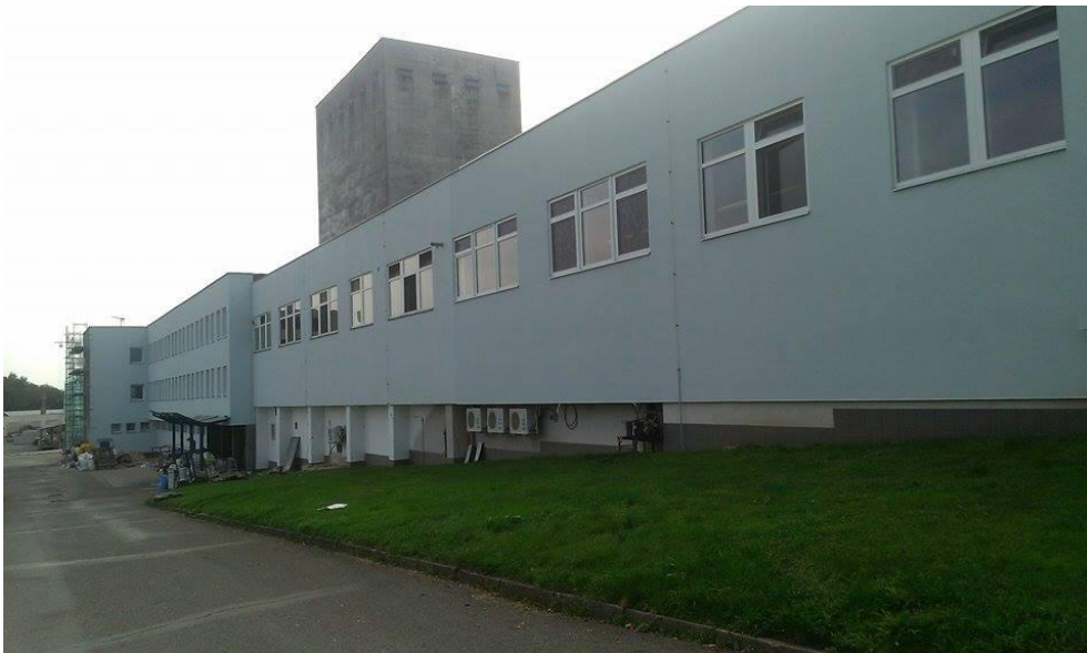
Obr. 13: Zateplená provozní budova a budova cukrárny [6]
