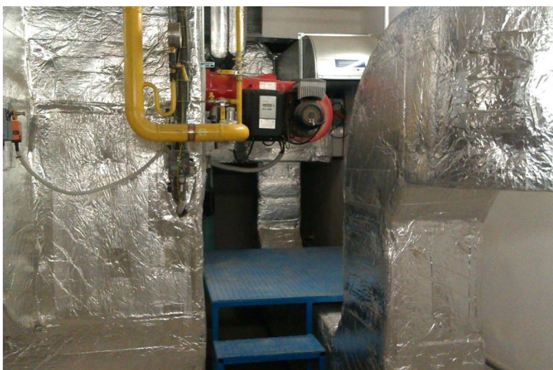
Obr. 20: Plynový hořák na hvozdu Foto: Autor
