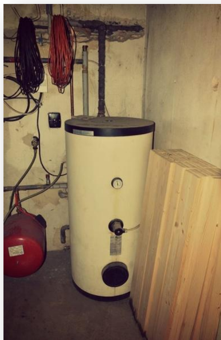
Obr. 4 – Zásobník teplé vody Foto: Autor
