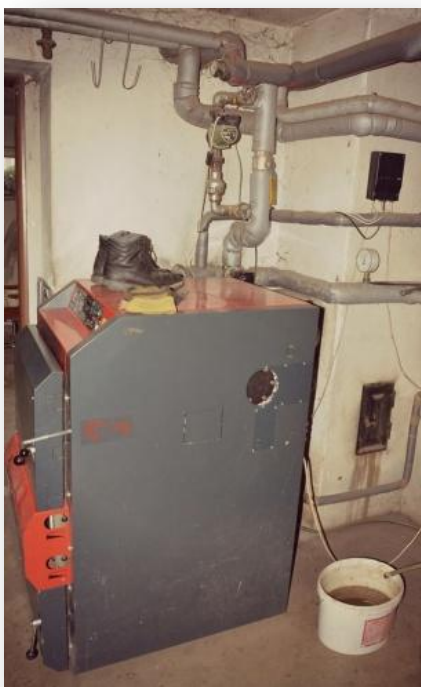
Obr. 3 – Kotel na dřevo Foto: Autor
