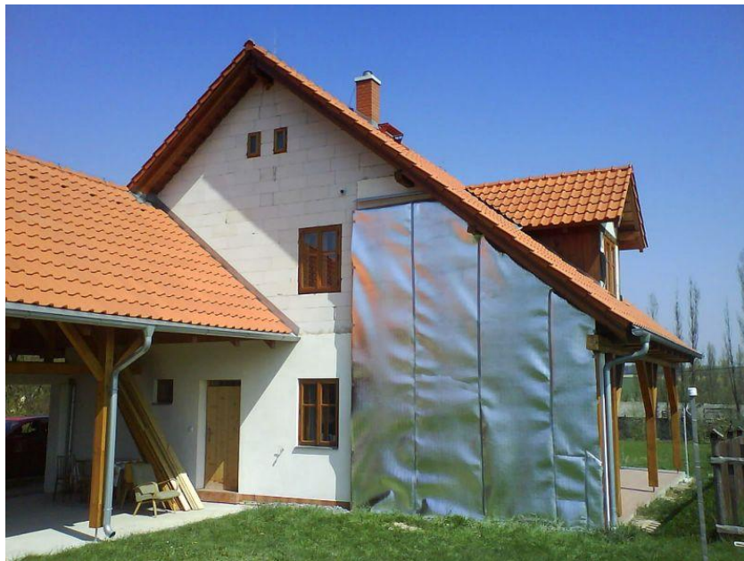
Stěna zakrytá fólií
