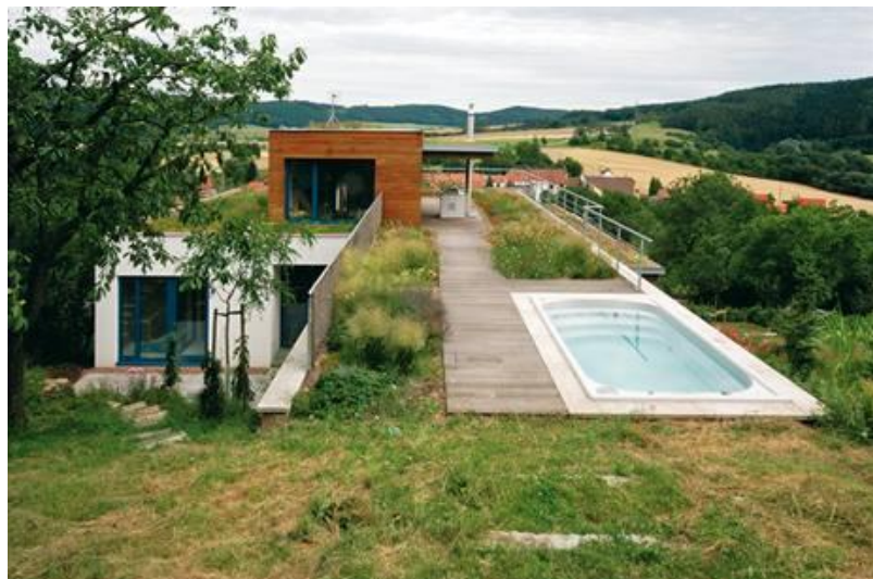
Zelené střechy se hodí ve svahu. Na přechodu horní terasy do terénu je situován bazén
