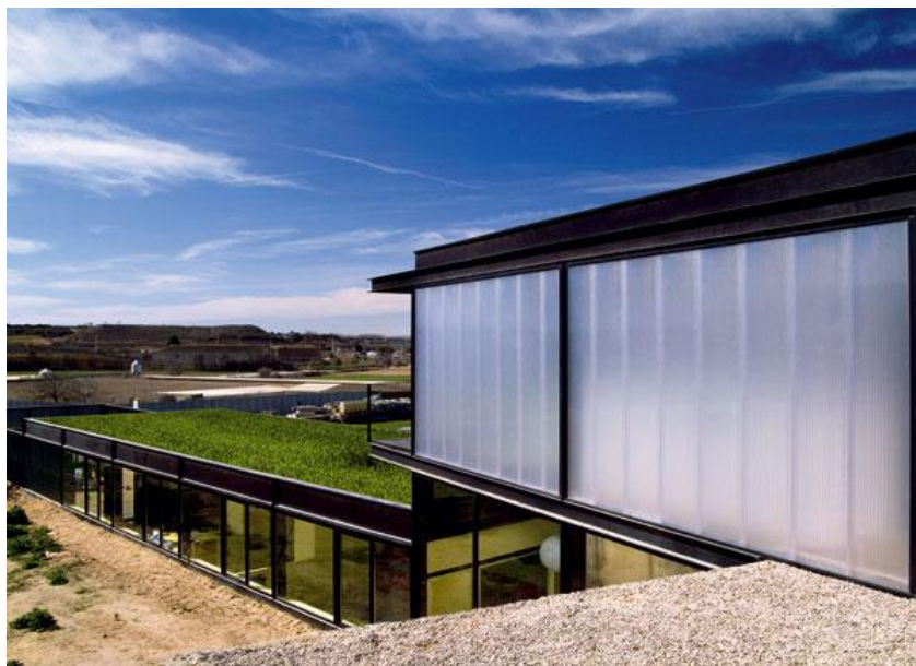
Zatavněná střecha chrání i maskuje.
